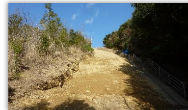
復旧中の被災法面
