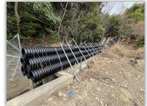
仮復旧工事中の排水施設
